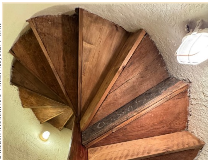
Zrestaurované schodiště na kůr v kostele Marky Boží Na Náměti
