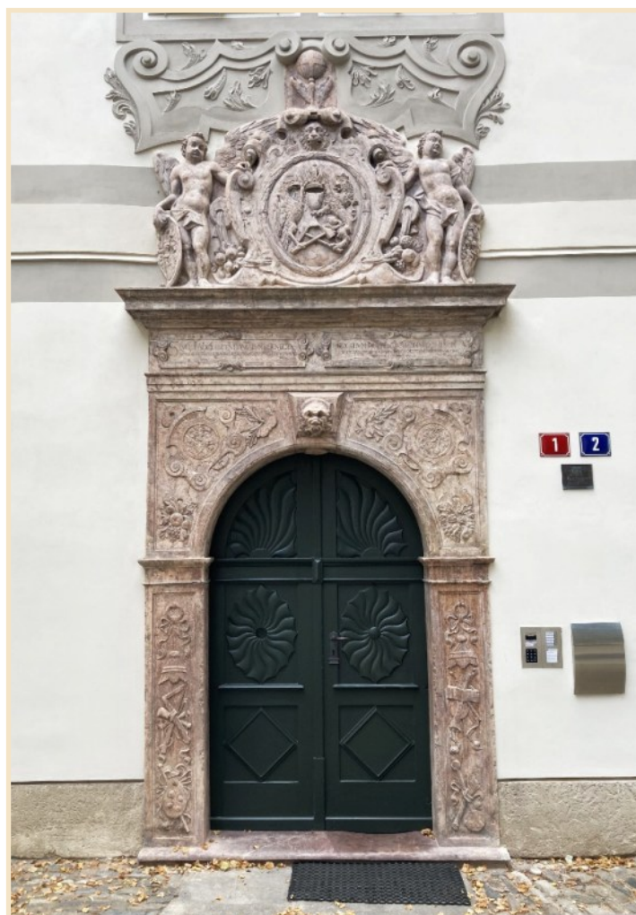
Vstupní portál na arciděkanství po restaurování
