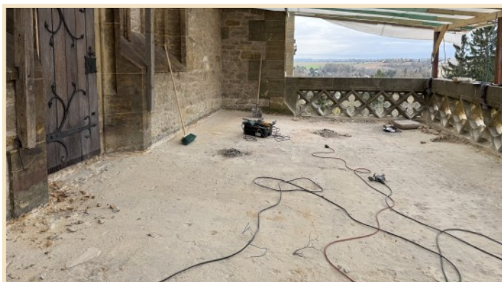
Terasa po odstranění hydroizolačního souvrství
