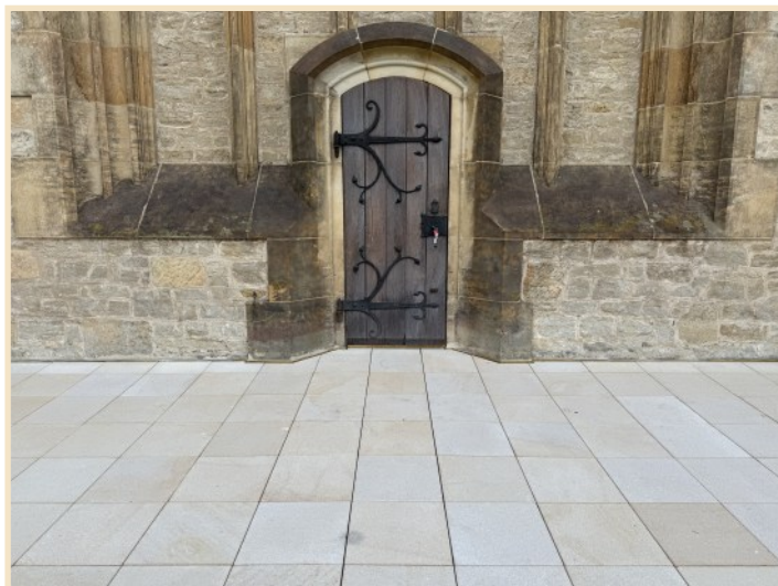
Terasa západního portiku po rekonstrukci
