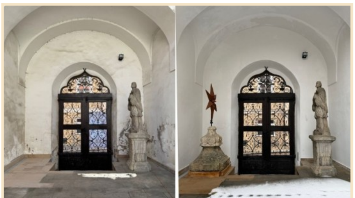
Obnova omítek v prostoru soutky mezi kostelem a Spolkovým domem
