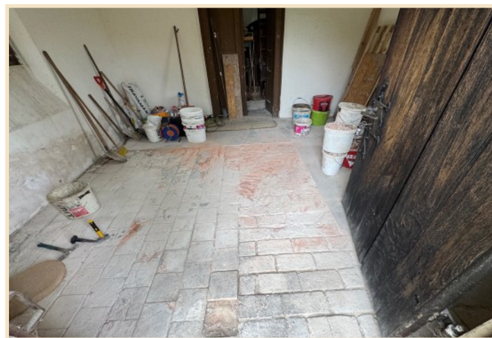
Prostor márníce v Gruntě před obnovou a vestavbou
