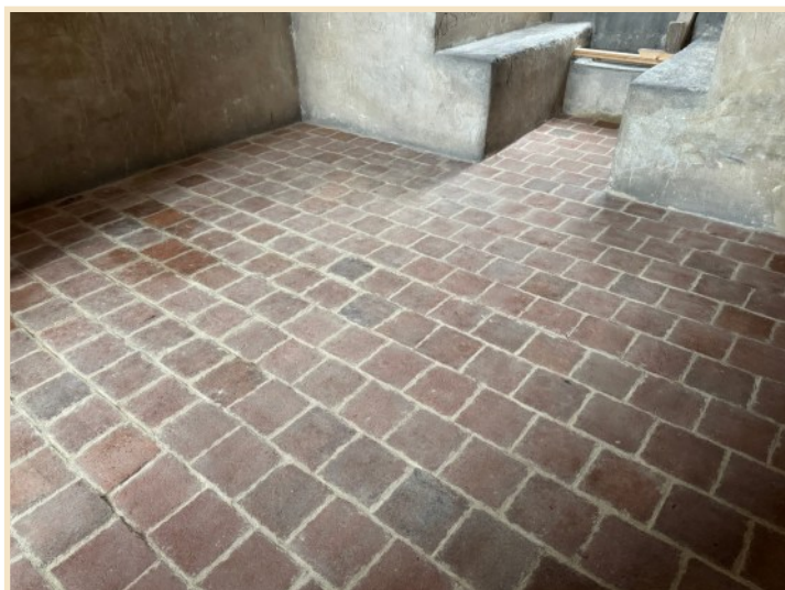
Obnovená podlaha v pokladnici kostela Matky Boží Na Náměti
