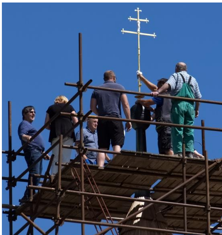
Instalace kříže na věž kostela v Chlístovicích. Foto Jan Šmok
