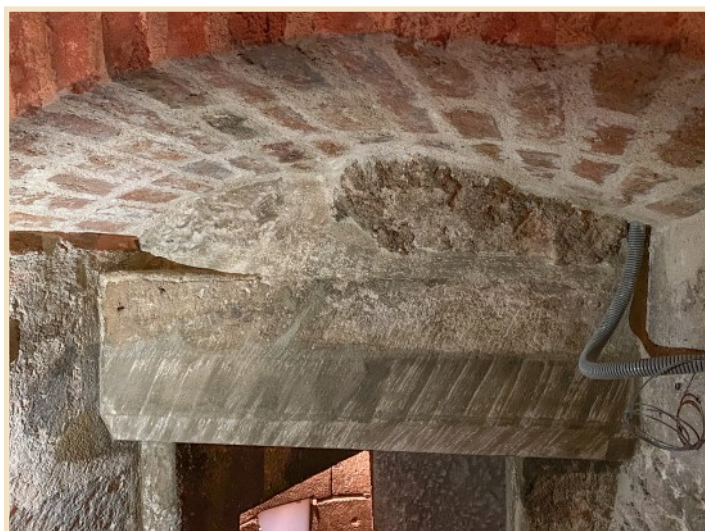
Ostění vstupu do krovu po statickém zajištění (2023)
