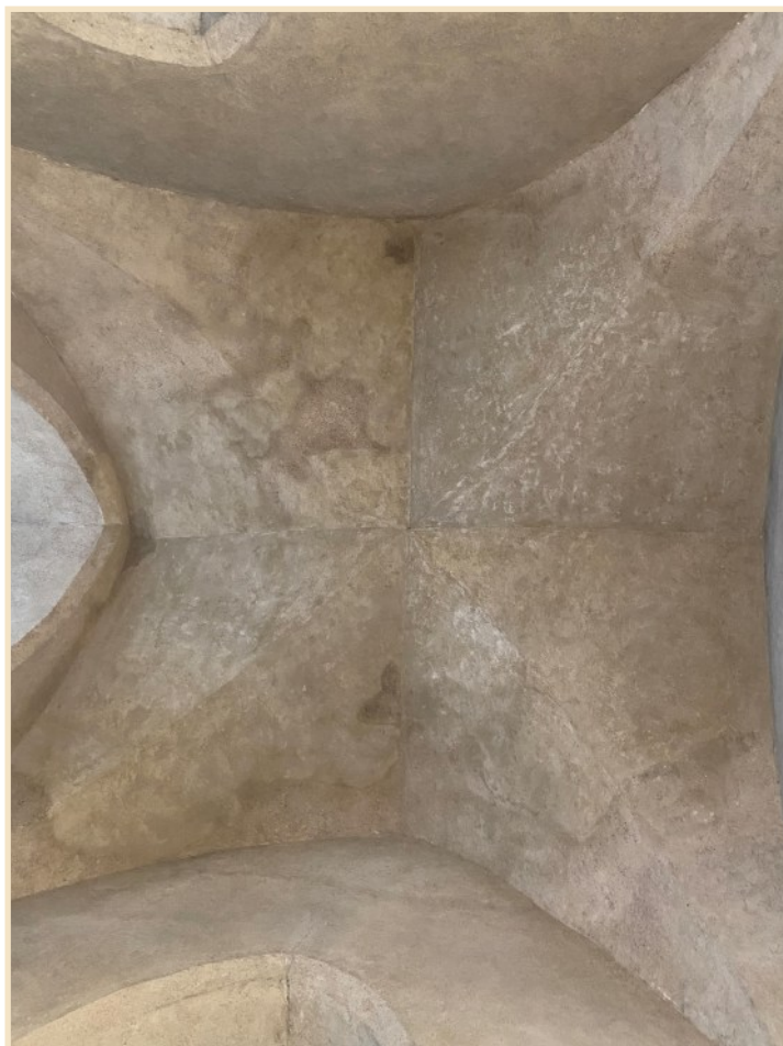
Klenba síně po obnově (2026)
