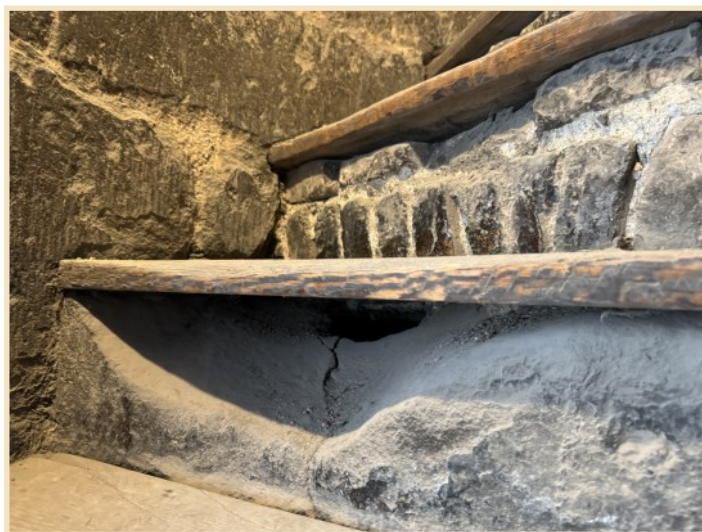
Vřetení do věže před obnovou (2024)
